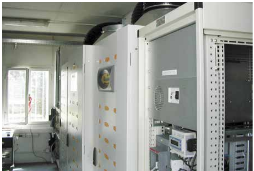
Convertitore di interfaccia della rete sperimentale in corrente continua nella Test Facility di RSE.
