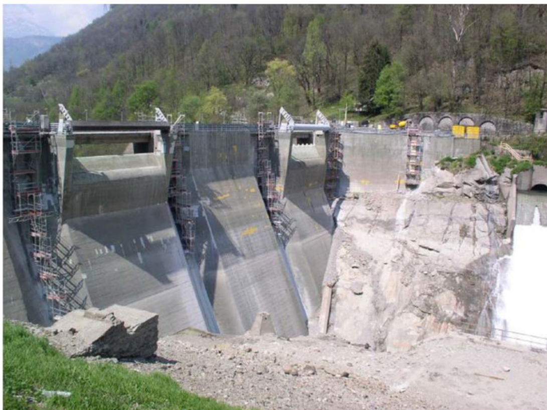
Figura 4 – Ripristino della diga di Poggia, sulla base delle indagini di R.S.E.
