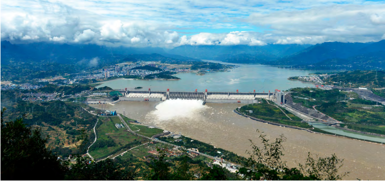
Diga di Three Gorges in Cina.
